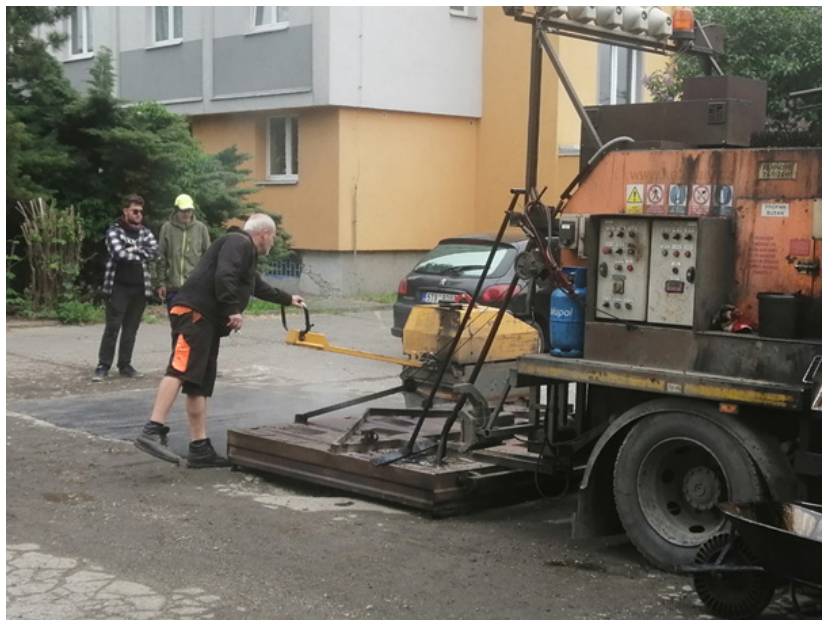
■ Obyvatelé domů na ulici Slavíkova se dne 18.5. – konečně po mnoha letech odkladů – dočkali opravy parkoviště.
